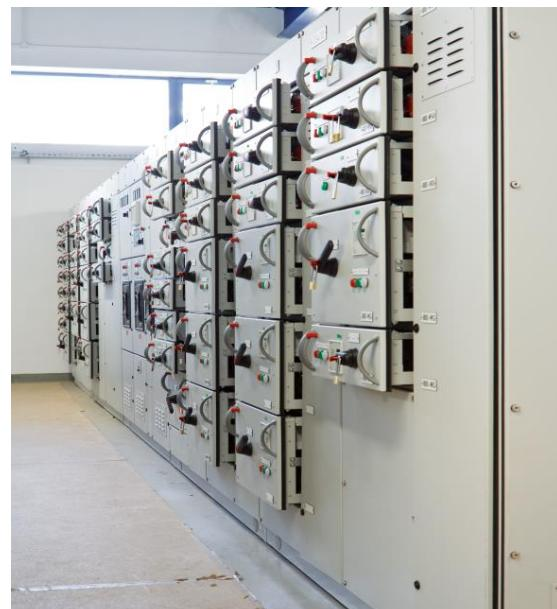
Los distintos tipos de módulos (fijos, amovibles y extraíbles) se combinan para lograr soluciones eficientes técnica y económicamente
